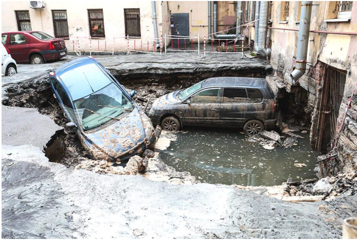
Провал грунта после прорыва трубы с горячей водой на Измайловском проспекте в 2018 году. В результате ЧП под землю провалились два автомобиля.
